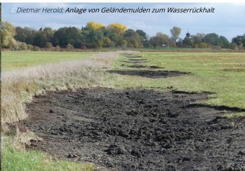
*©Dietmar Herold; Anlage von Geländemulden zum Wasserrückhalt*
